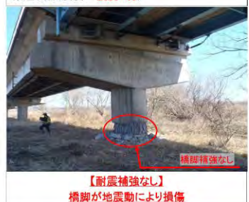
県道(観測震度: 震度5弱)
