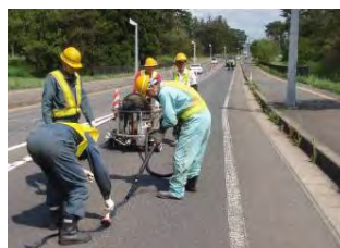
補修工事 (クラックシール注入)
