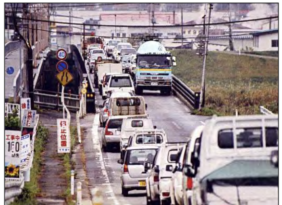
狭隘な老朽橋
