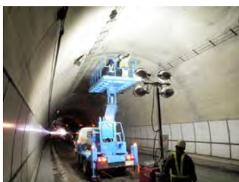
トンネル詳細定期点検
