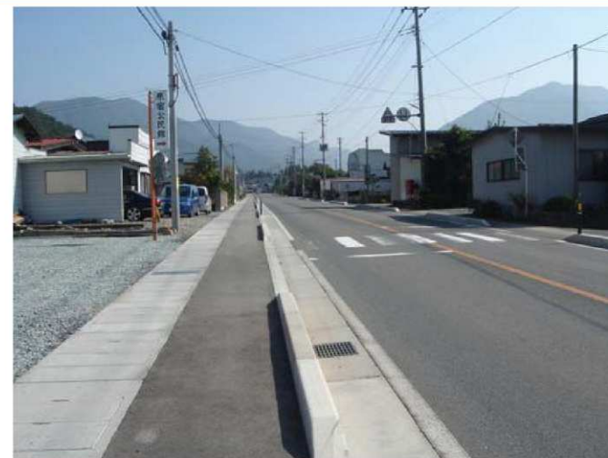
▲歩道及び路肩拡幅 後
