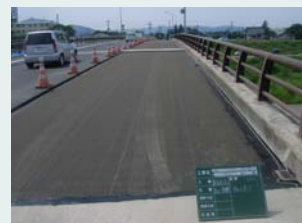
橋面防水工の施工
